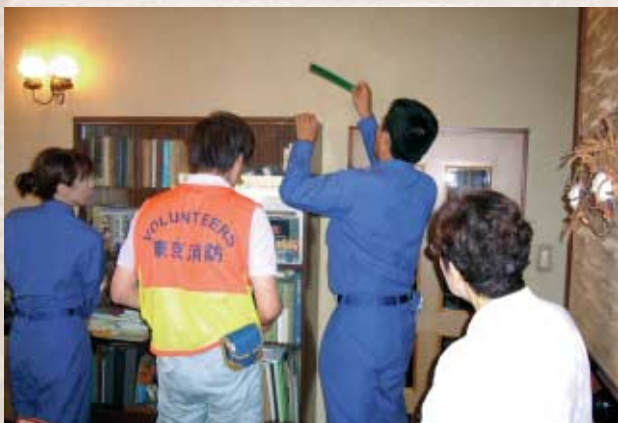
家具の転倒防止金具の取り付けの様子
